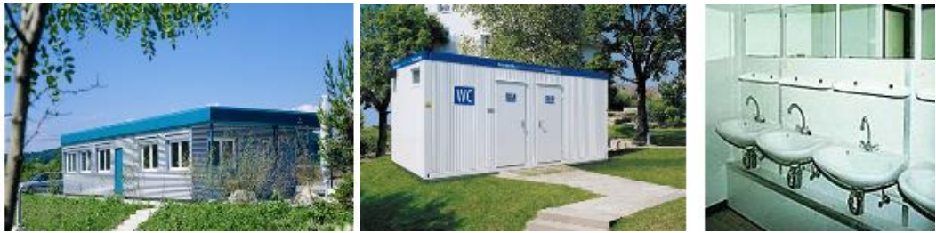
Abb. 6.16 Beispiel für Aufenthaltsraum und Sanitäranlagen in Form von Containern / Elementbauten.
